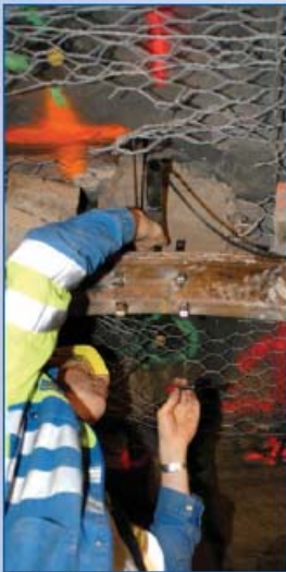
Galerie à l'étage - 490 m (section des mesures, avril 2005)
