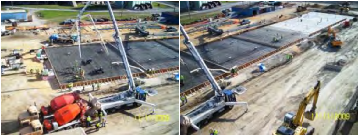
Figure 3.2-29 Pad Pour at the Perry ISFSI
